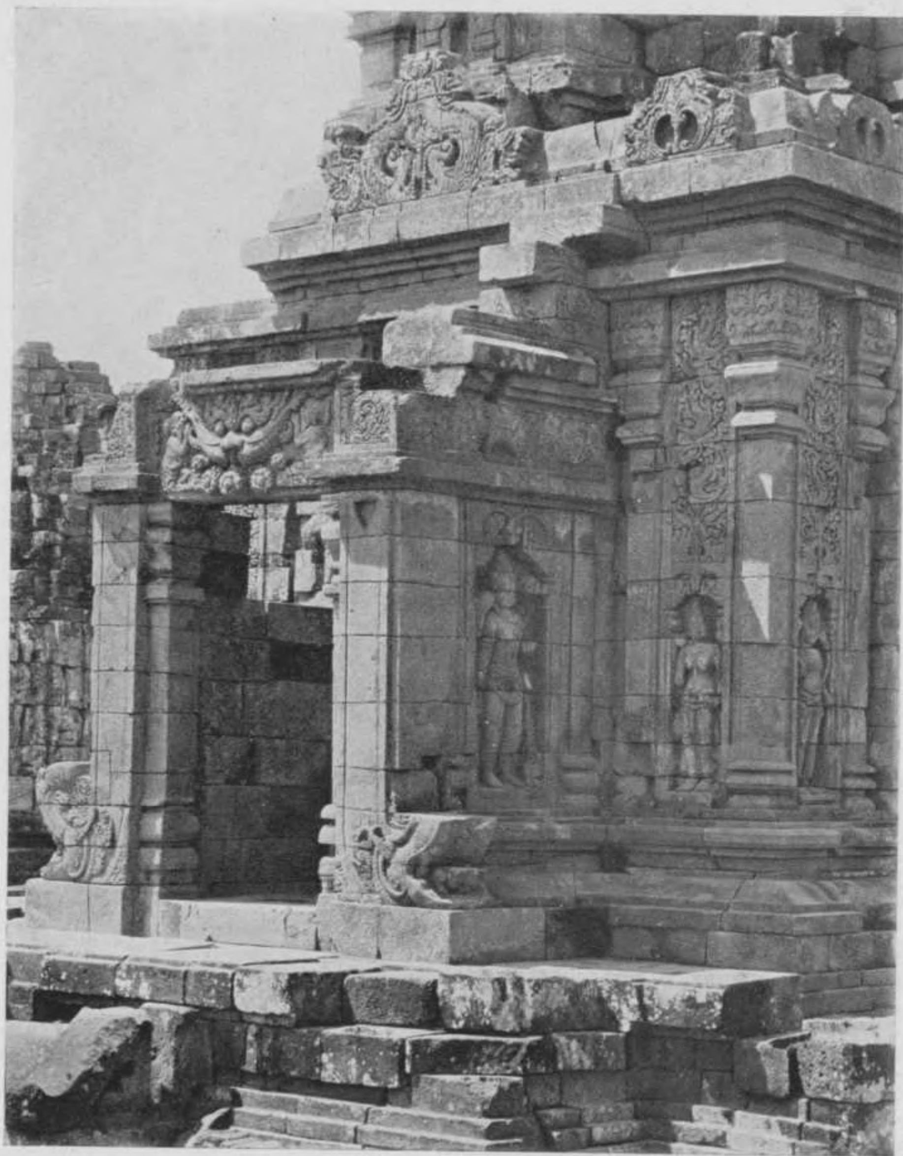
Geveldetail met portiek van de I e reeks.
